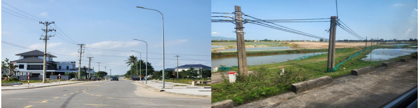
Hình 17: Hiện trạng cấp điện
